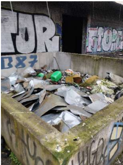
Vue sur une rétention (Nord du site)
