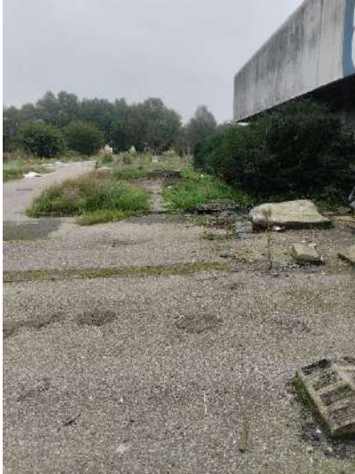
Vue sur la cuve enterrée (Nord du site)
