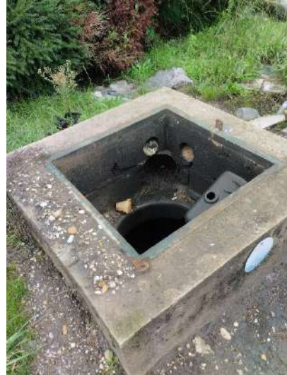
Vue sur le trou d'homme de la cuve enterrée (Nord du site)
