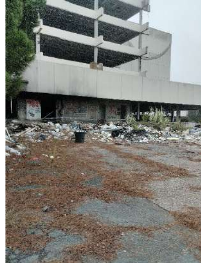
Vue sur le Sud du site
