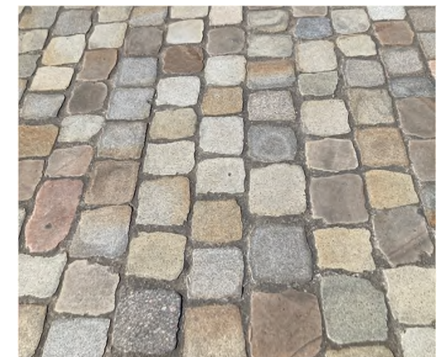
Pavés de récupération 13x20cm en granit Zone circulaire (SDIS33, VL) - Joints mortier
