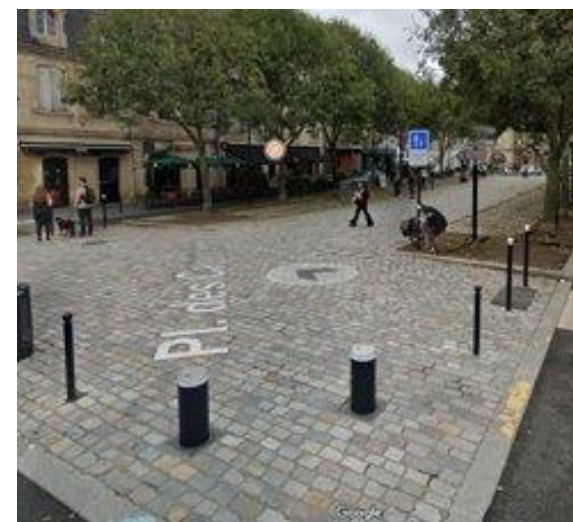
Matériaux de la place : pavés granit de récupération (exemple : Place des Capucins)
