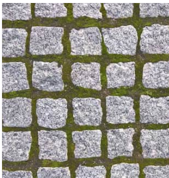
Pavé granit de réemploi joints enherbés
