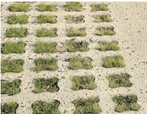
Béton alvéolaire végétalisé (coulé en place)
