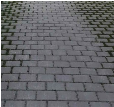
Pavé béton joints mortier
